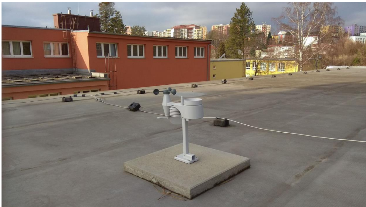
Projekt Modernizace – meteorologická stanice na střeše školy
